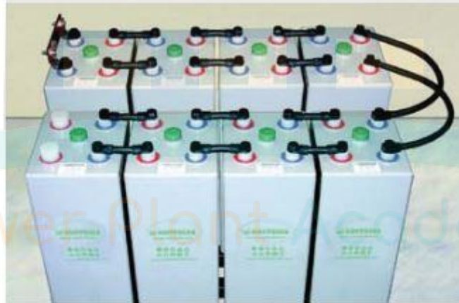
شکل (۲-۶) نحوه اتصال کانکتور ردیفی و کانکتور رشته‌ها
