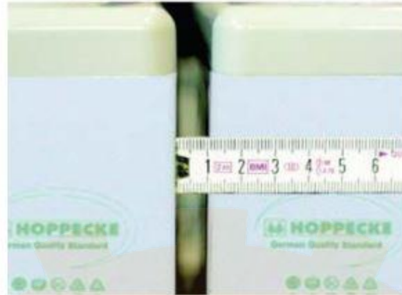
تصویر (۲-۵) ۱۰ میلیمتر فاصله‌ی خالی بین باتری‌ها
