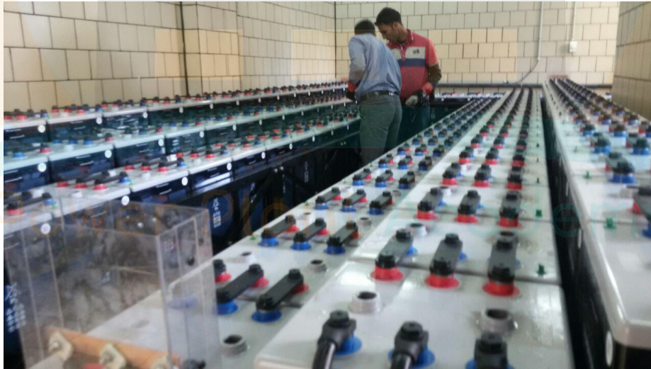
شکل (۱-۳۳) تمیز کردن باطری در باطری خانه نیروگاه دماوند
