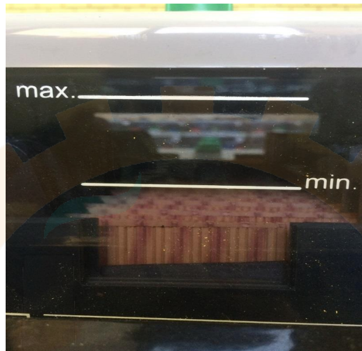
شکل (۱۴-۱) نمای سطوح max و min مشخص شده بر روی سلول باتری GroE
