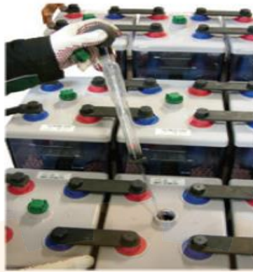
شکل (۱۷-۱) هیدرومتر
